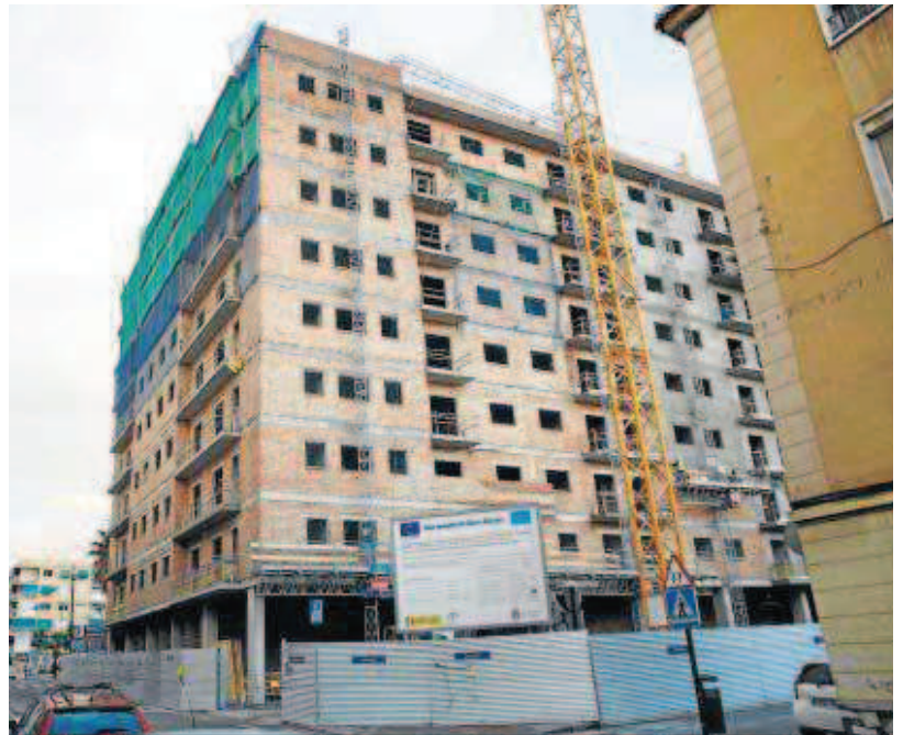
Construcción de viviendas en Granada.
