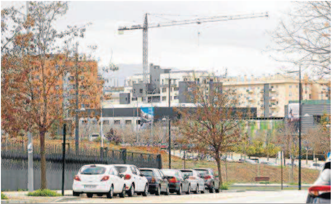
La construcción ya está certificando su salida de la crisis.
