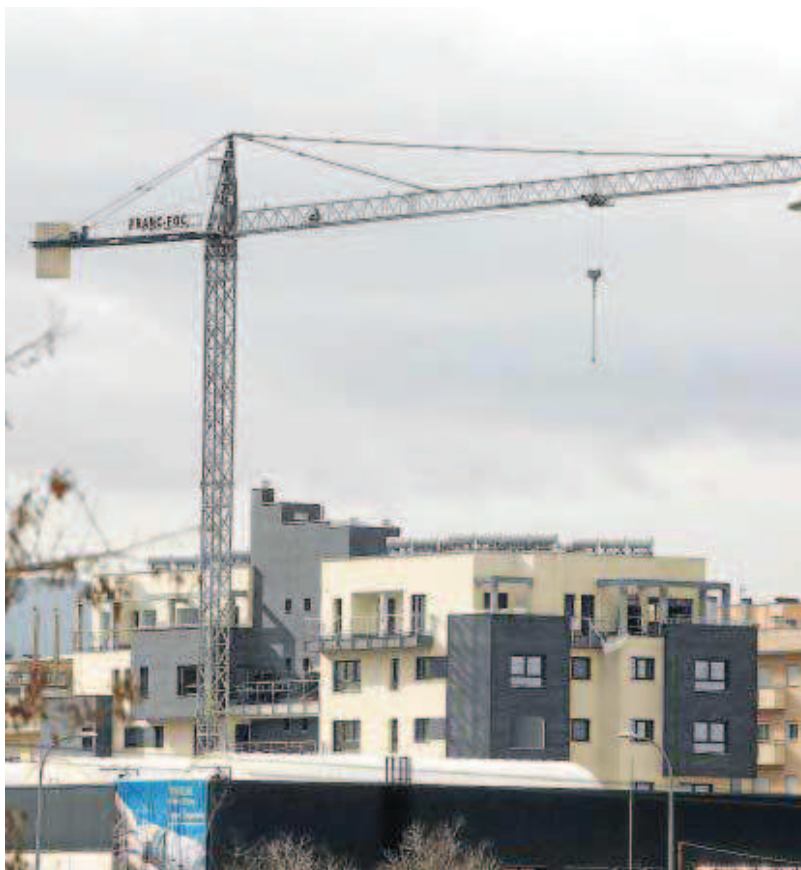
Obras de nueva construcción en la capital.
